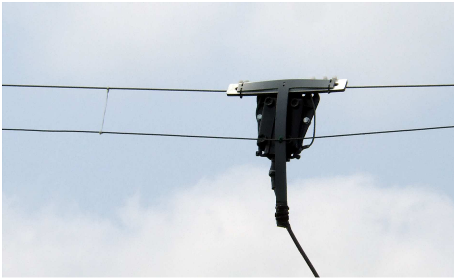
Abb.6: Antennendose (Balun-Gehäuse) mit einem T-Abstandshalter zur Zugentlastung des Koaxkabels
